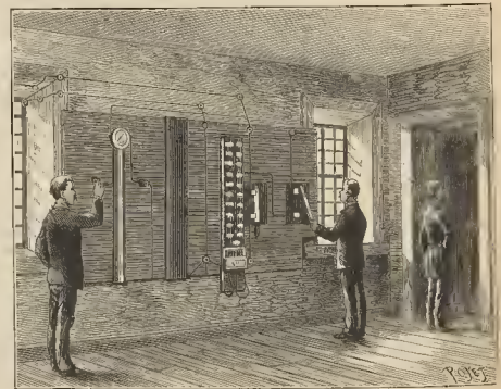
Primera ejecución eléctrica. - Cuadro de órdenes que ha servido para la misma
